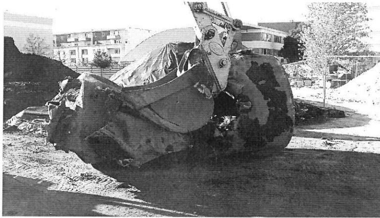
Figure 13 : Cuve découverte extraite
