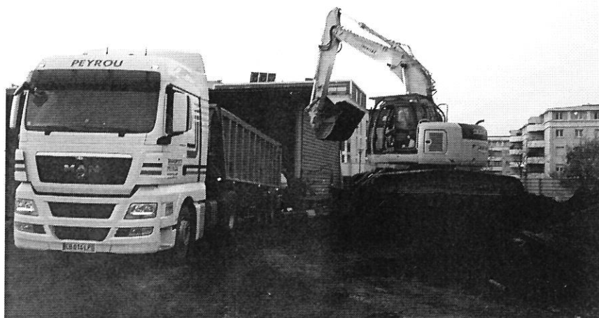
Figure 14 : Chargement des bennes TP bâchées
