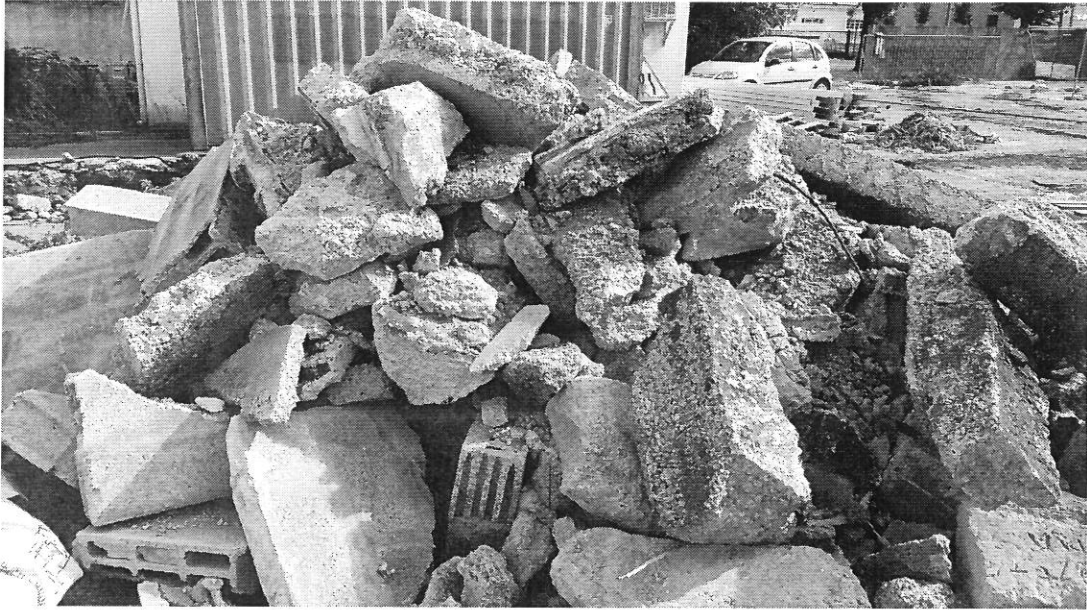
Figure 5 : Tri des bétons sains pour valorisation en remblaiement
