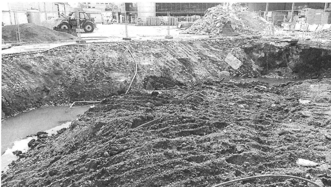
Figure 9 : Zone de terrassement des terres polluées
