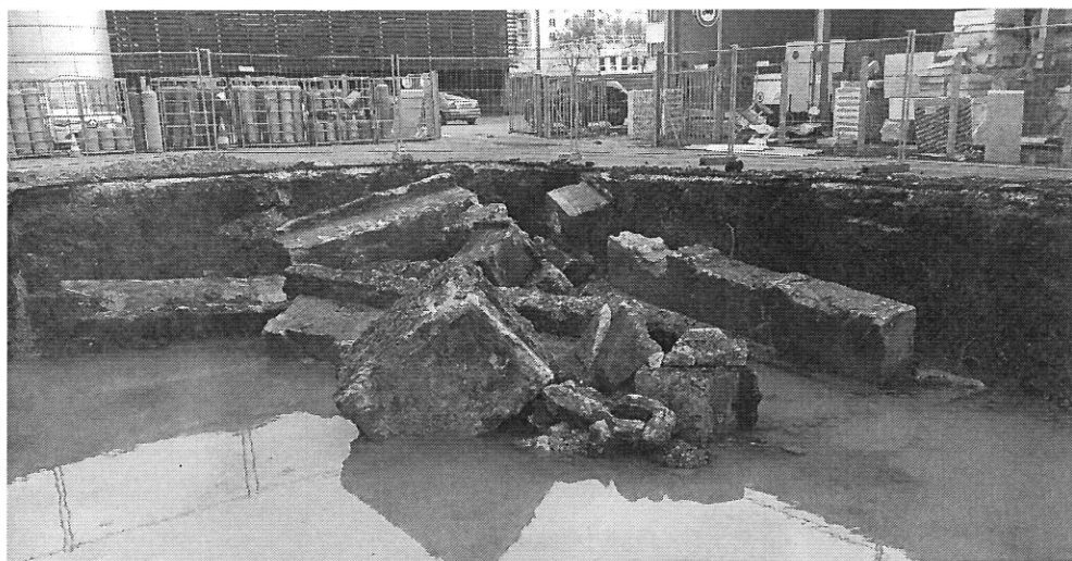
Figure 15 : Photo des longrines
