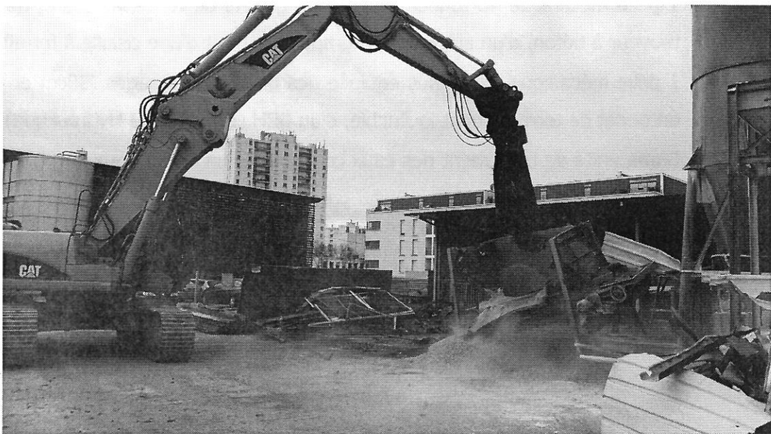
Figure 4 : Démantèlement des bâtiments
