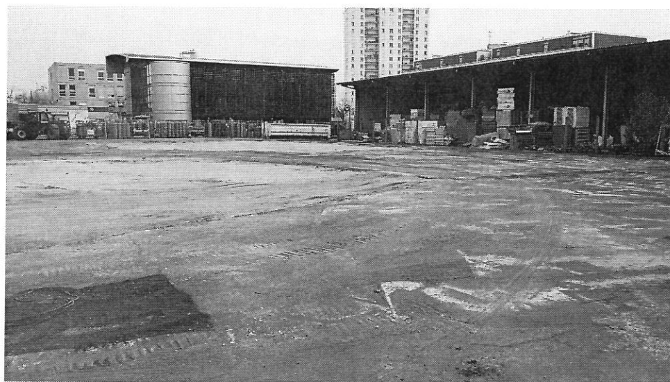
Figure 20 : Photo de fin de travaux
