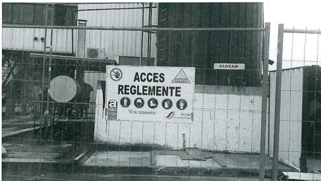
Figure 3 : Balisage du chantier de désamiantage
