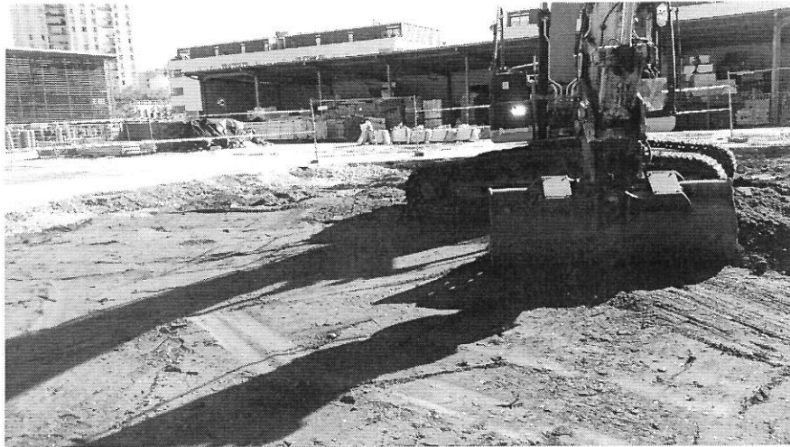
Figure 17 : Remblaiement des fouilles
